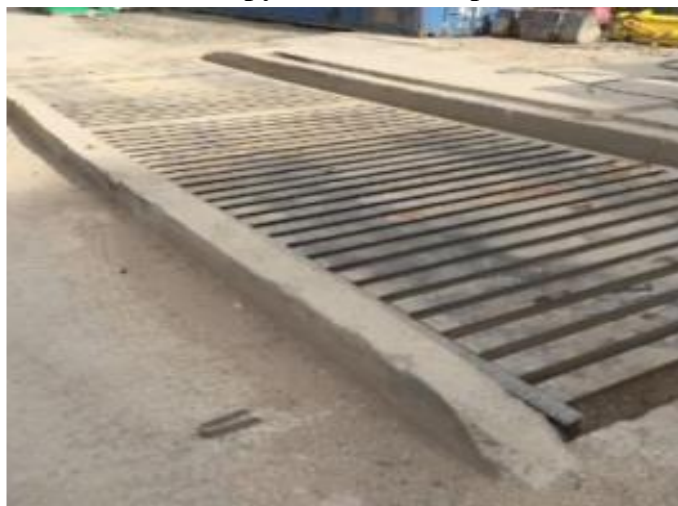
Мойка оборудованная, с приемком.
