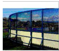
Глухой барьер - водостойкая ламинированная фанера, высота 1,5 м Ограждение - сетчатые панели высотой 2,0 м по металлическим столбам высотой 3,5 м
