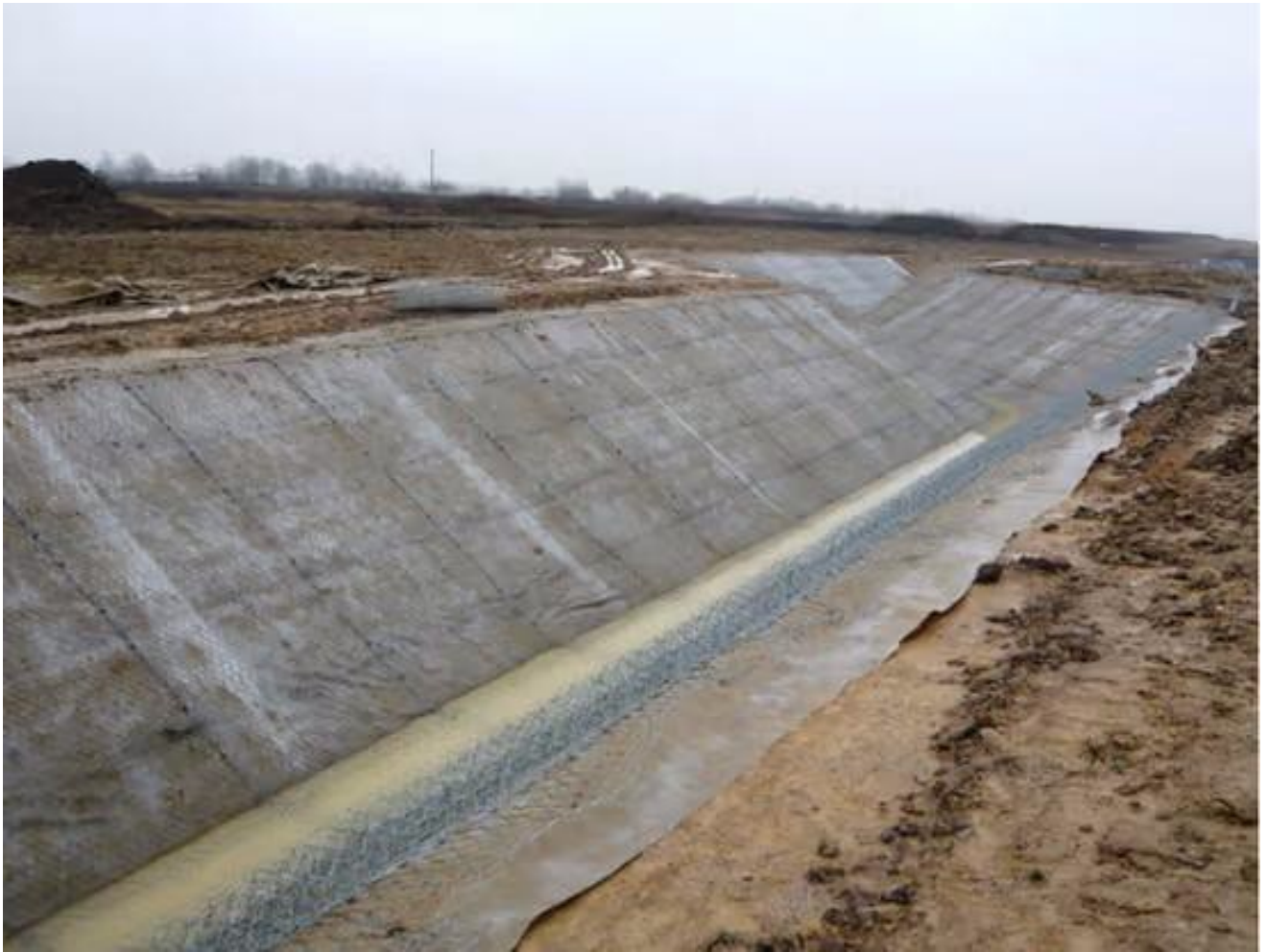
Пример укладки габионов
