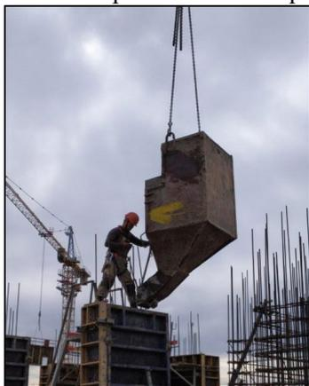
Рис. 5.2 – Бетонирование колонн
