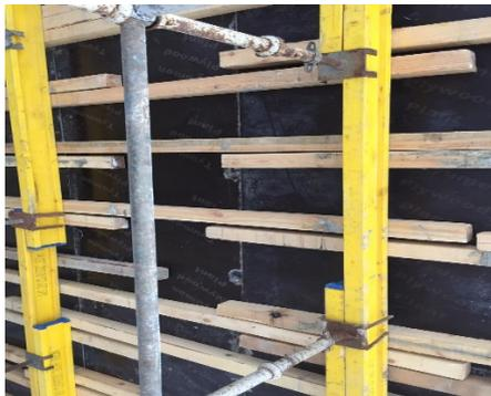
Рис. 5.1 – Схема установки балки на брус
