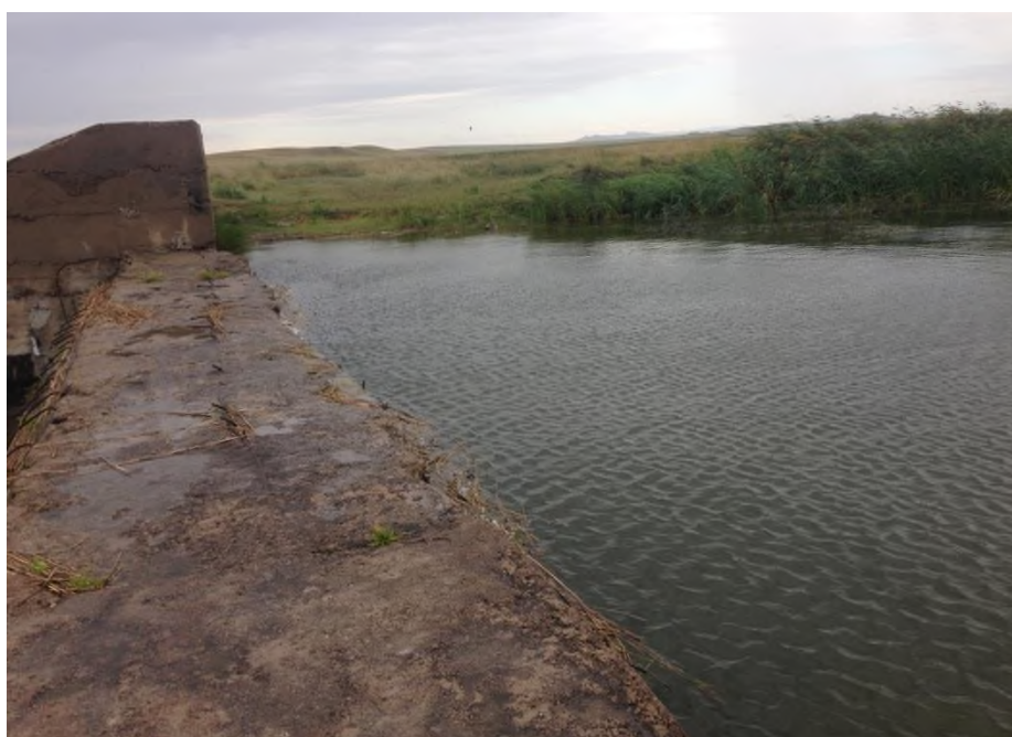
Рисунок 1 – Гидротехническое сооружение на озере Курбет
