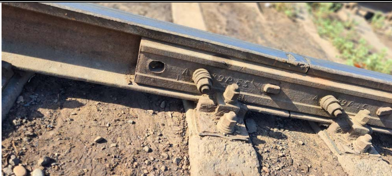
Фото №10 по обследованию подъездных железнодорожных путей №15, 17 ст.Белкуль расположенный в г.Кызылорда, Кызылординской области.
