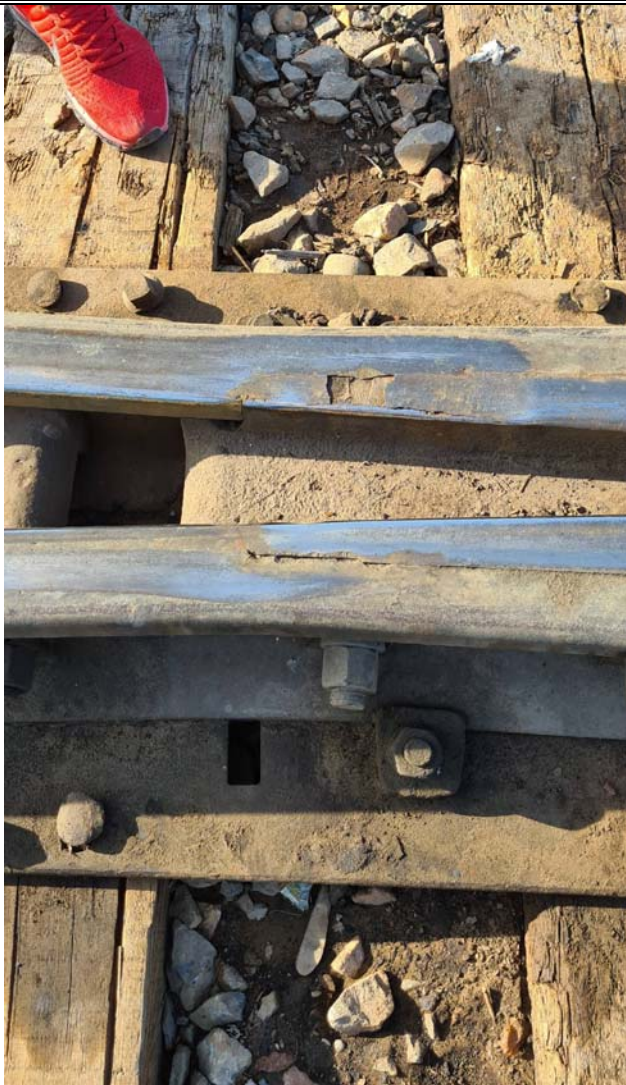
Фото № 29 по обследованию подъездных железнодорожных путей №15, 17 ст.Белкуль расположенный в г.Кызылорда, Кызылординской области.
