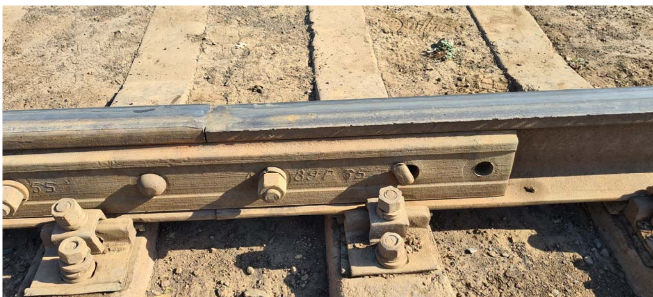
Фото № 6 по обследованию подъездных железнодорожных путей №15, 17 ст.Белкуль расположенный в г.Кызылорда, Кызылординской области.
