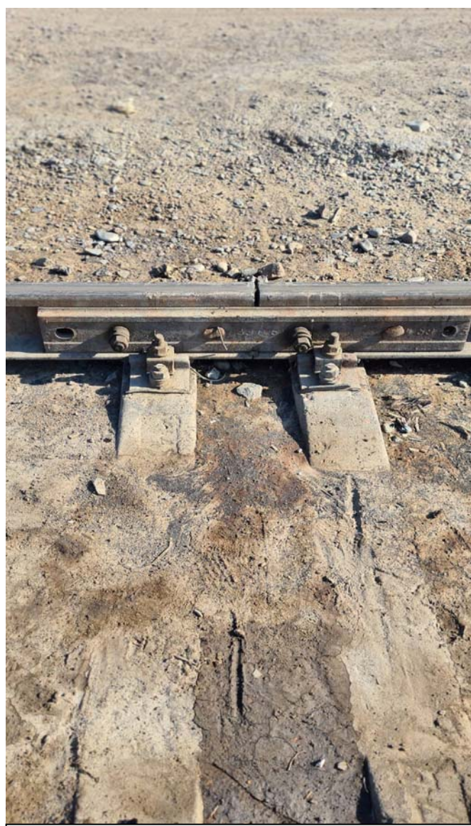
Фото № 18 по обследованию подъездных железнодорожных путей №15, 17 ст.Белкуль расположенный в г.Кызылорда, Кызылординской области.
