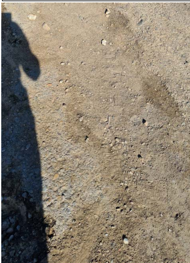
Фото № 27 по обследованию подъездных железнодорожных путей №15, 17 ст.Белкуль расположенный в г.Кызылорда, Кызылординской области.
