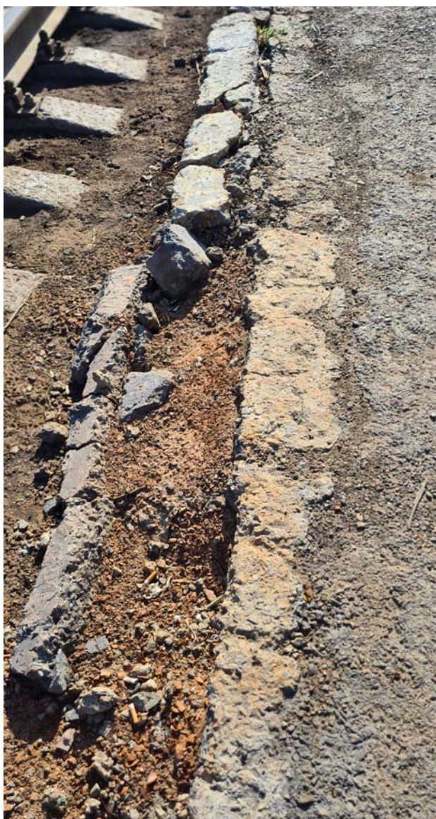
Фото № 17 по обследованию подъездных железнодорожных путей №15, 17 ст.Белкуль расположенный в г.Кызылорда, Кызылординской области.
