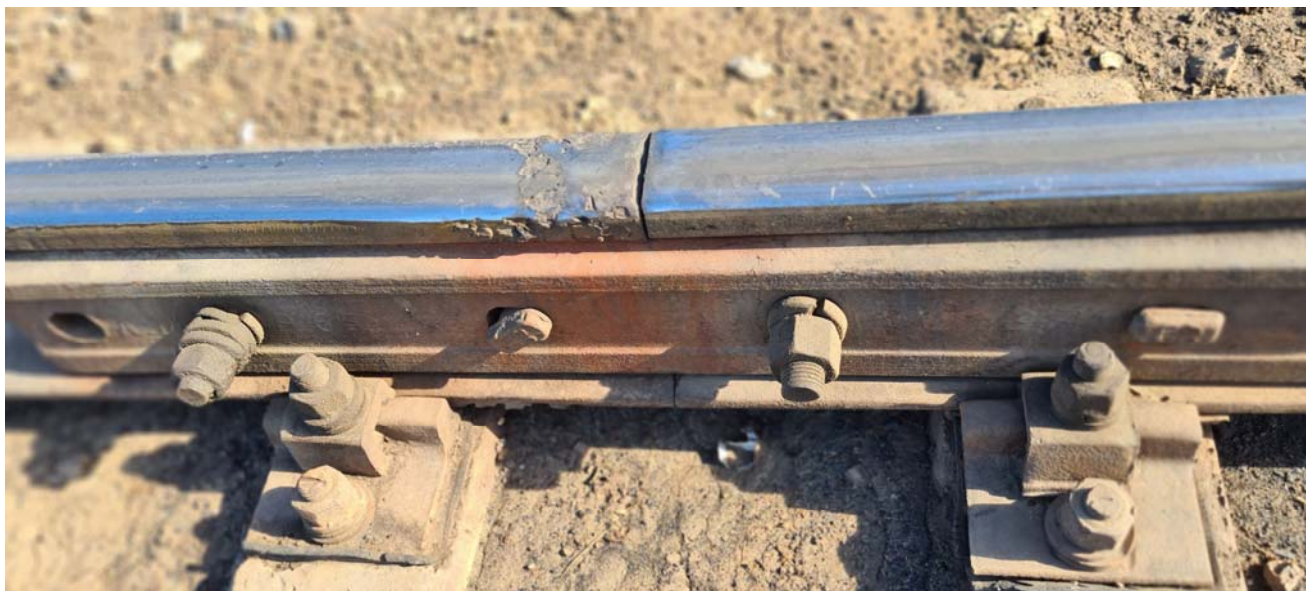
Фото № 7 по обследованию подъездных железнодорожных путей №15, 17 ст.Белкуль расположенный в г.Кызылорда, Кызылординской области.
