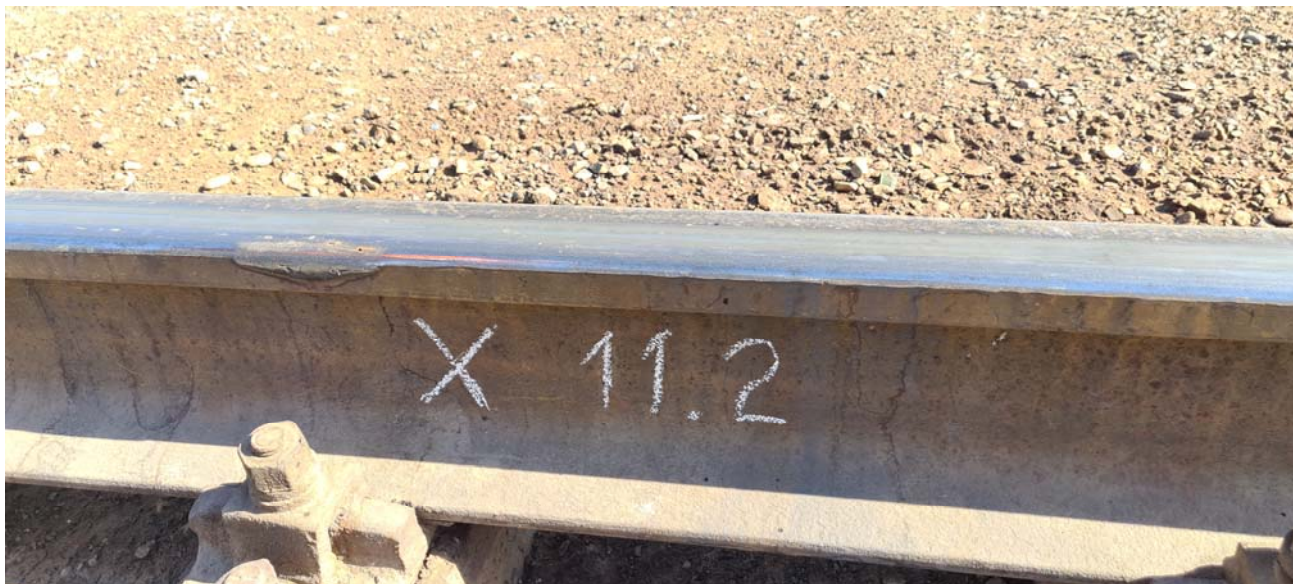
Фото № 1 по обследованию подъездных железнодорожных путей №15, 17 ст.Белкуль расположенный в г.Кызылорда, Кызылординской области.
