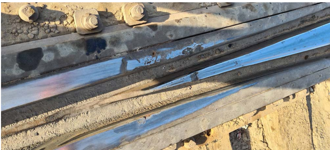
Фото № 31 по обследованию подъездных железнодорожных путей №15, 17 ст.Белкуль расположенный в г.Кызылорда, Кызылординской области.
