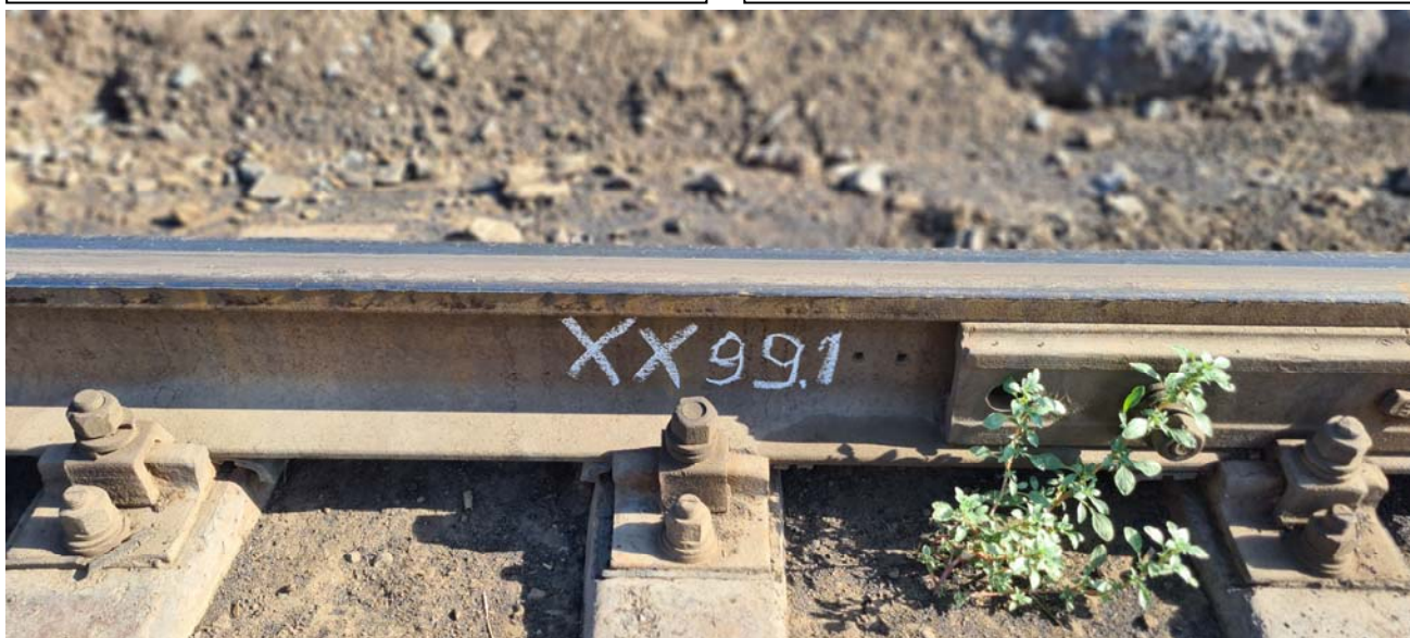
Фото № 15 по обследованию подъездных железнодорожных путей №15, 17 ст.Белкуль расположенный в г.Кызылорда, Кызылординской области.
