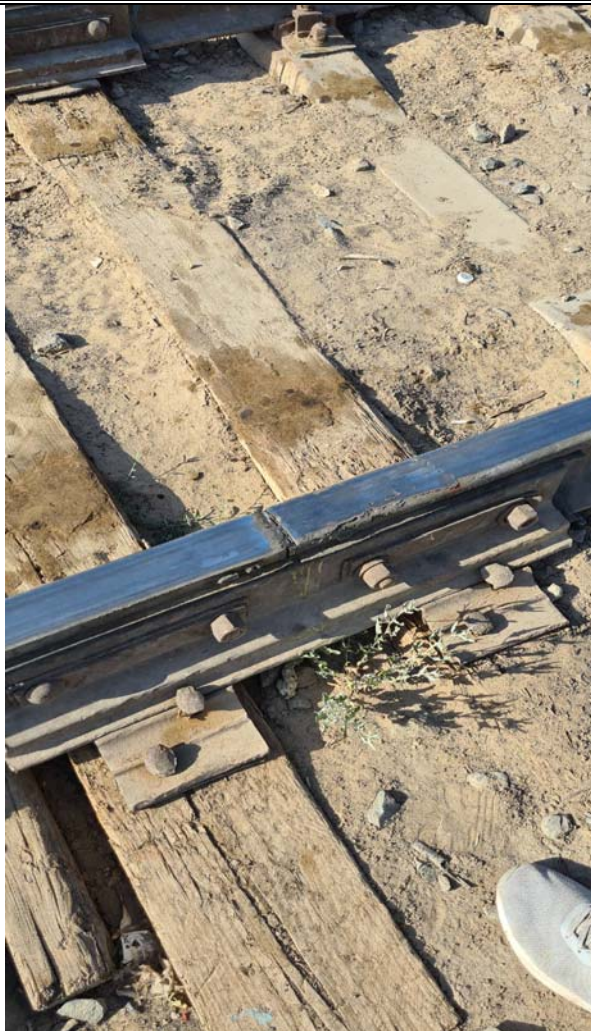
Фото № 22 по обследованию подъездных железнодорожных путей №15, 17 ст.Белкуль расположенный в г.Кызылорда, Кызылординской области.
