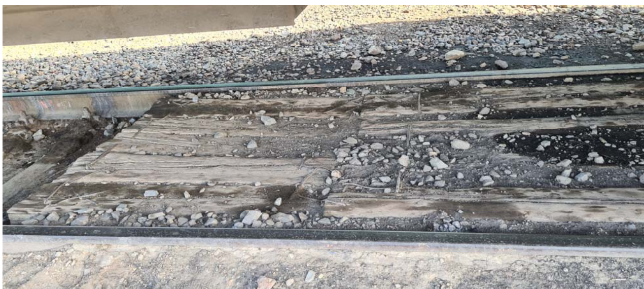
Фото № 21 по обследованию подъездных железнодорожных путей №15, 17 ст.Белкуль расположенный в г.Кызылорда, Кызылординской области.
