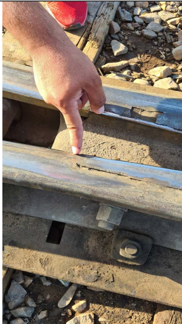
Фото № 30 по обследованию подъездных железнодорожных путей №15, 17 ст.Белкуль расположенный в г.Кызылорда, Кызылординской области.
