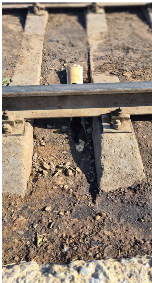
Фото № 3 по обследованию подъездных железнодорожных путей №15, 17 ст.Белкуль расположенный в г.Кызылорда, Кызылординской области.
