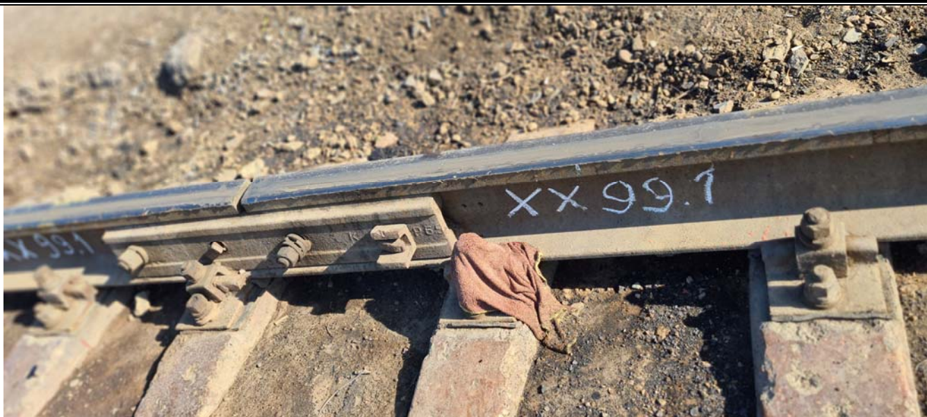
Фото № 16 по обследованию подъездных железнодорожных путей №15, 17 ст.Белкуль расположенный в г.Кызылорда, Кызылординской области.
