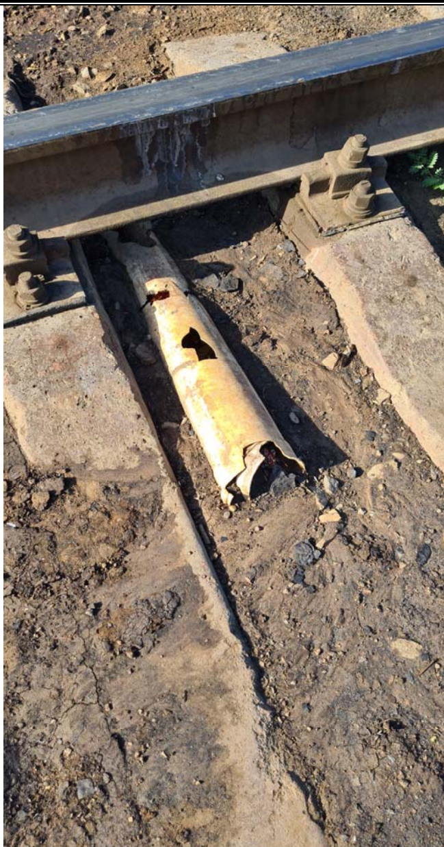
Фото № 13 по обследованию подъездных железнодорожных путей №15, 17 ст.Белкуль расположенный в г.Кызылорда, Кызылординской области.
