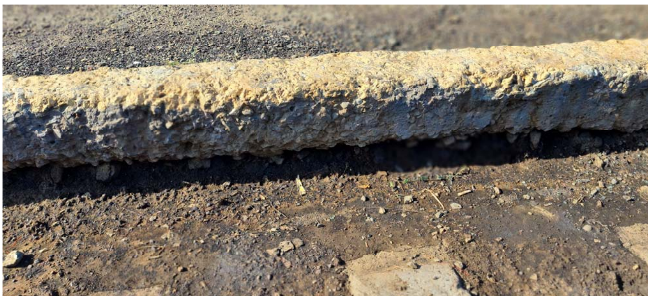
Фото № 24 по обследованию подъездных железнодорожных путей №15, 17 ст.Белкуль расположенный в г.Кызылорда, Кызылординской области.
