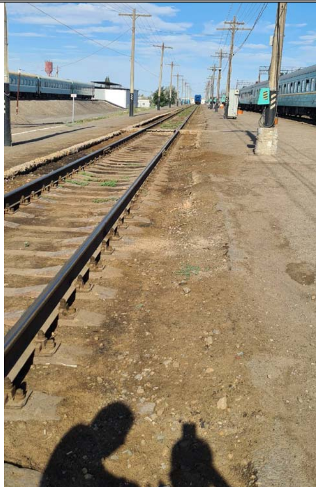
Фото № 26 по обследованию подъездных железнодорожных путей №15, 17 ст.Белкуль расположенный в г.Кызылорда, Кызылординской области.
