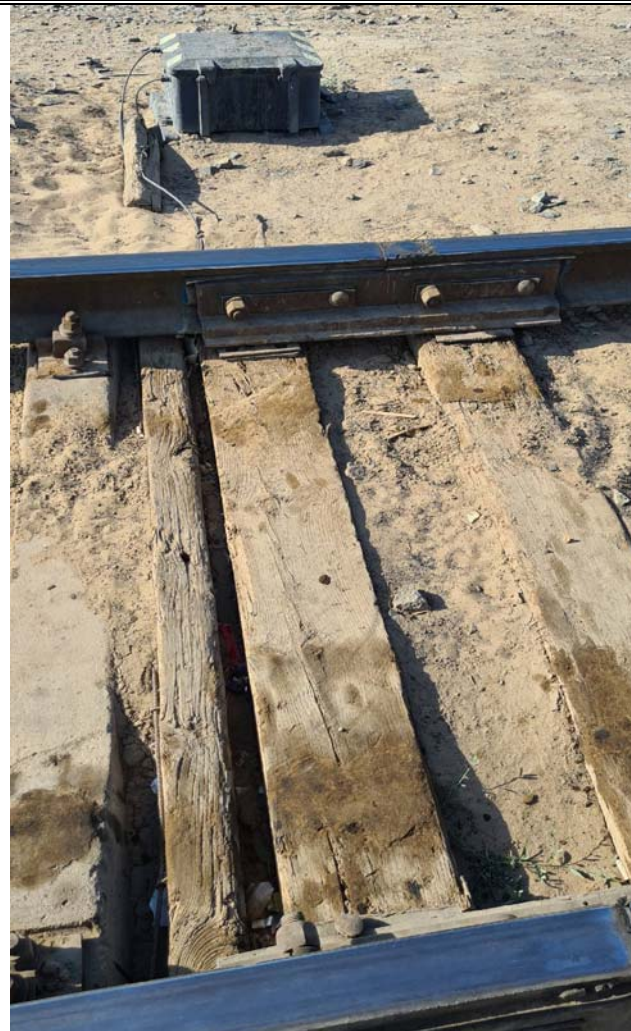
Фото № 23 по обследованию подъездных железнодорожных путей №15, 17 ст.Белкуль расположенный в г.Кызылорда, Кызылординской области.
