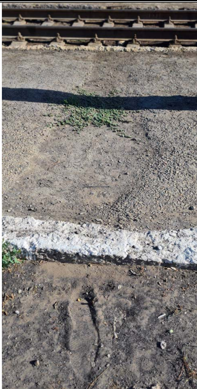
Фото № 14 по обследованию подъездных железнодорожных путей №15, 17 ст.Белкуль расположенный в г.Кызылорда, Кызылординской области.
