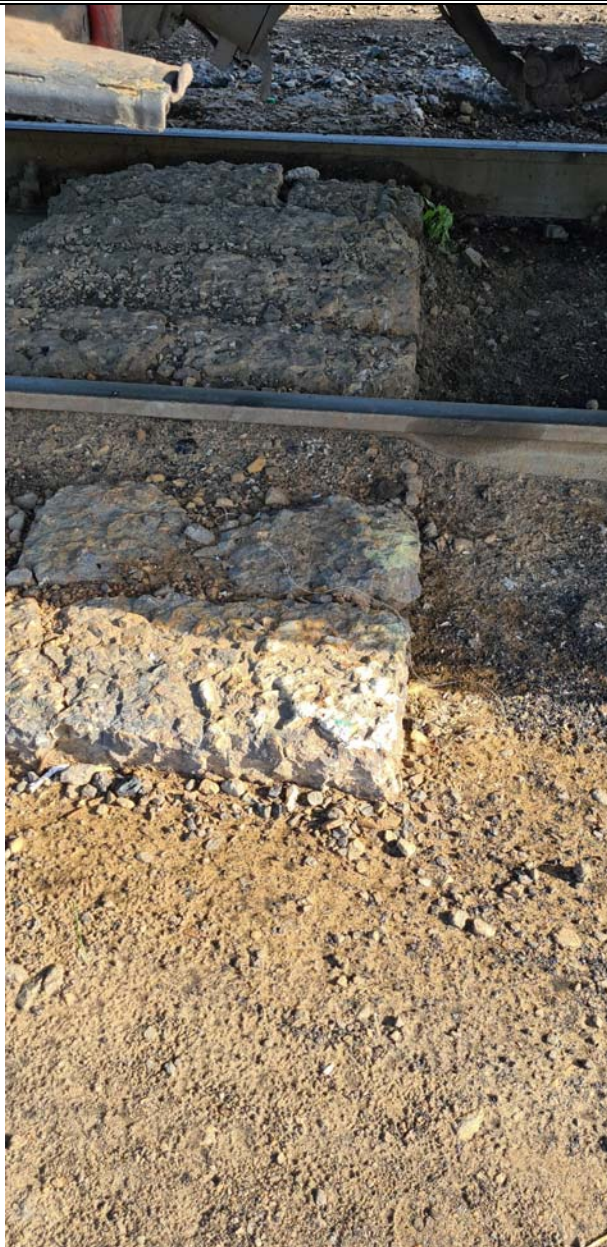
Фото № 19 по обследованию подъездных железнодорожных путей №15, 17 ст.Белкуль расположенный в г.Кызылорда, Кызылординской области.
