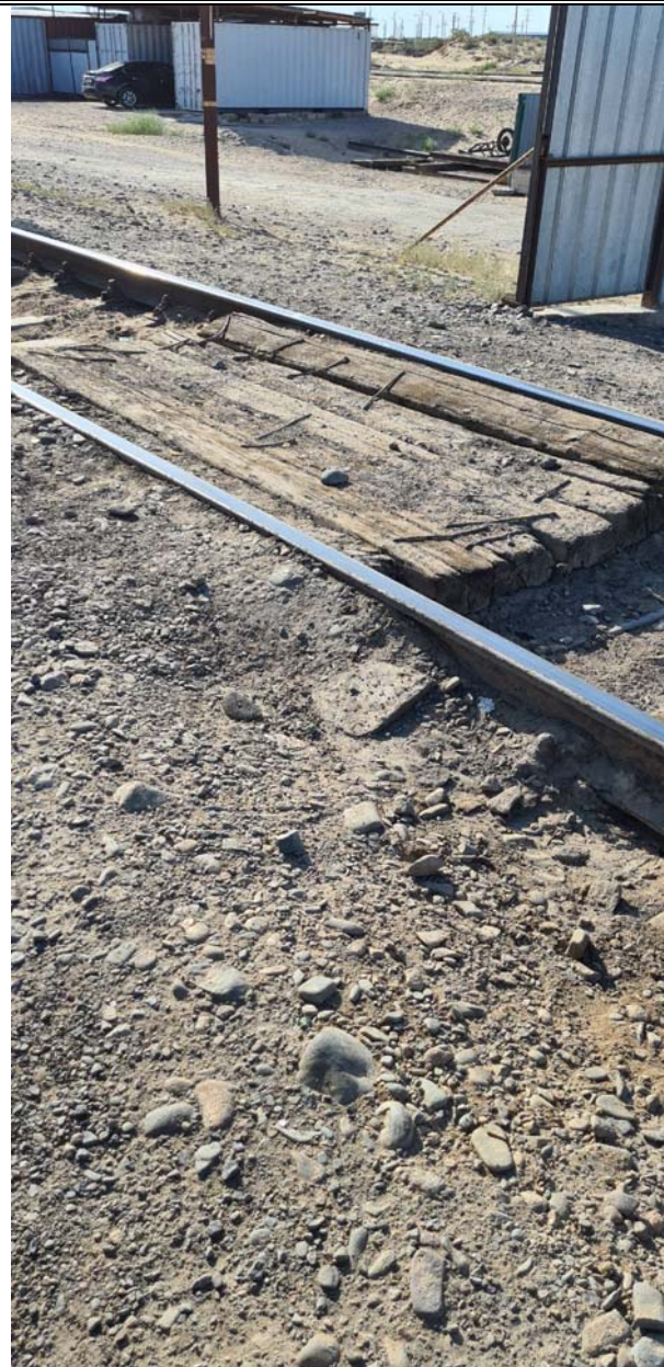
Фото №20 по обследованию подъездных железнодорожных путей №15, 17 ст.Белкуль расположенный в г.Кызылорда, Кызылординской области.
