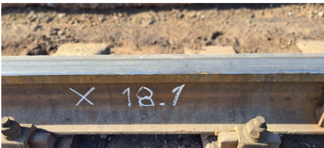
Фото № 11 по обследованию подъездных железнодорожных путей №15, 17 ст.Белкуль расположенный в г.Кызылорда, Кызылординской области.
