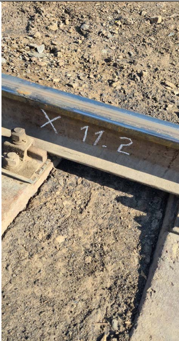
Фото № 4 по обследованию подъездных железнодорожных путей №15, 17 ст.Белкуль расположенный в г.Кызылорда, Кызылординской области.
