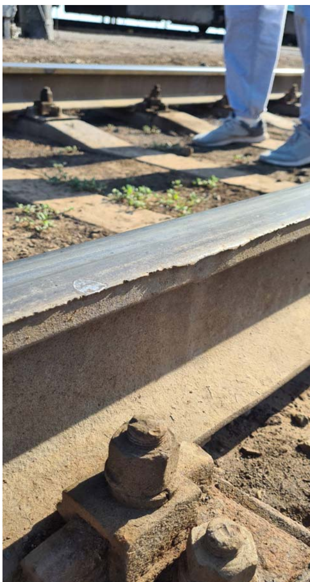
Фото № 2 по обследованию подъездных железнодорожных путей №15, 17 ст.Белкуль расположенный в г.Кызылорда, Кызылординской области.
