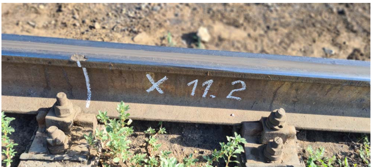
Фото № 12 по обследованию подъездных железнодорожных путей №15, 17 ст.Белкуль расположенный в г.Кызылорда, Кызылординской области.
