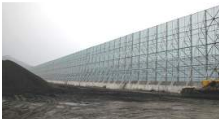
Рис.3.20 - Ограждение угольного склада
