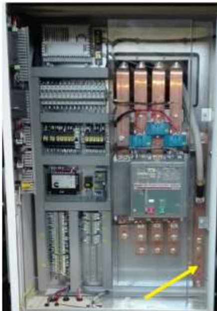
Рис. 4.2: Клемные колодки для заземления внутри панелей
