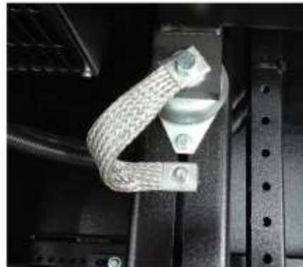
Рис. 4.1: Заземление внутренних компонентов
