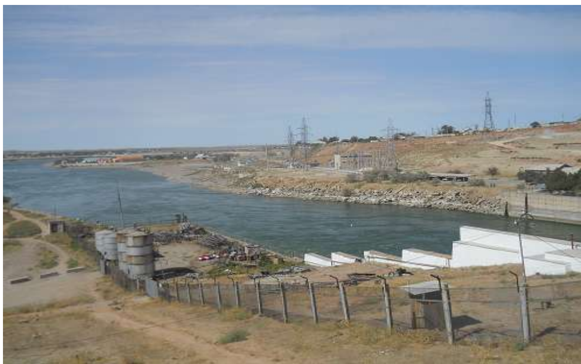
Фото 5.1 Общий вид на правобережье нижнего бьефа Шардаринского водохранилища.
