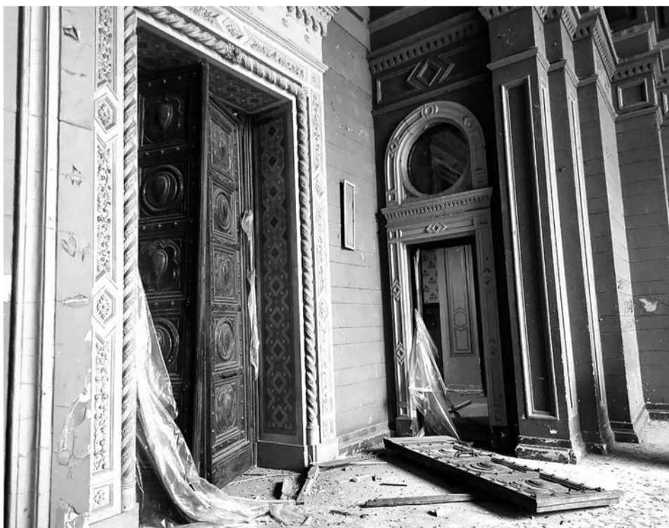
Поврежденные здания в результате удара по Одессе, 1 февраля 2025 года
