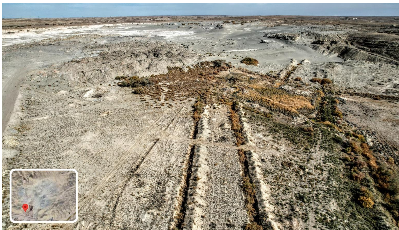
Фото 4.2.1 Территория промплощадки с траншеями и наносами хвостов на 10.10.2024 г.
