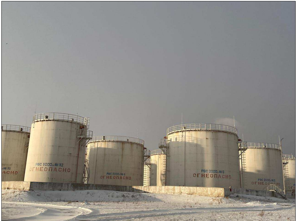
Рисунок 4.2 – Фотографический снимок резервуаров ТОО Нефтебаза «Достык» (вид 1)
