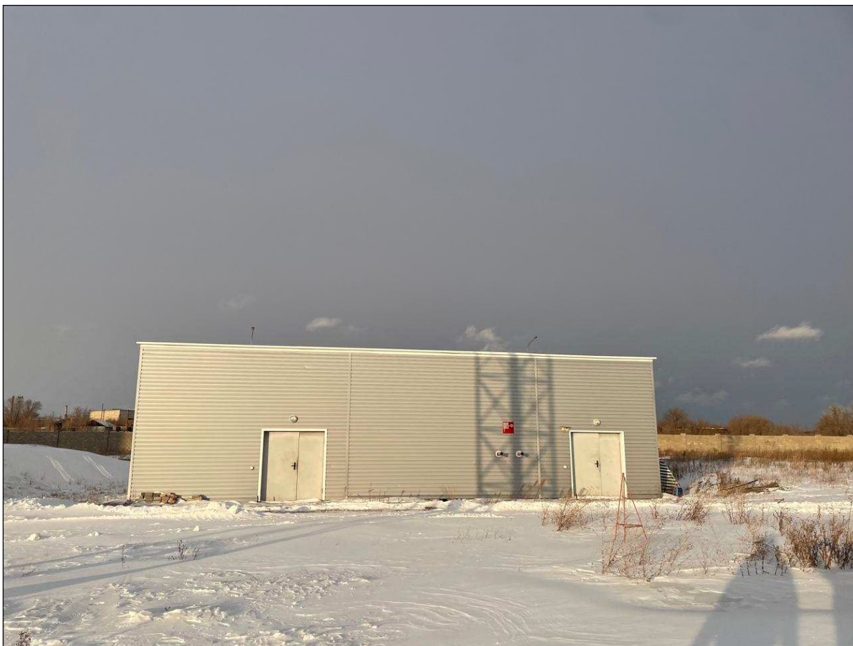
Рисунок 5.1 – Фотографический снимок автоматической пожарной сигнализации ТОО Нефтебаза «Достык»
