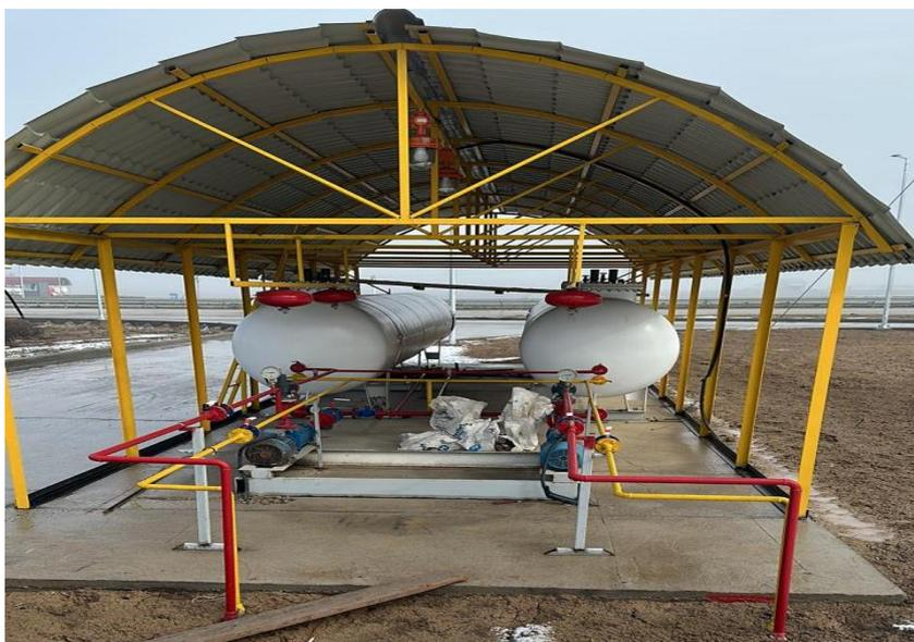
**Газозаправочная колонка.** Для заправки автомобилей СУГ предусмотрена электронная газозаправочная колонка типа FAS 120 производительностью 5-50 л/мин, сеть 230V,50Hz,
