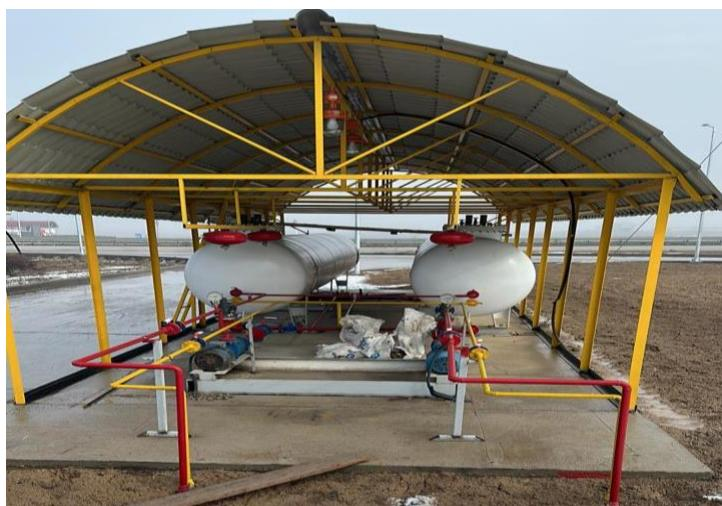
**Газозаправочные колонки.** Для заправки автомобилей СУГ предусмотрена электронная газозаправочная колонка типа FAS 120 производительностью 5-50 л/мин, сеть 230V,50Hz, корпус из нержавеющей стали, заправочным рукавом 19, длиной 4,5 м с многоразовой разрывной муфтой и скоростным клапаном. Имеется встроенное табло и насосный агрегат с сальниковым уплотнением, байпасным клапаном с дополнительной обводной линией. Колонка оснащена основными компонентами:
