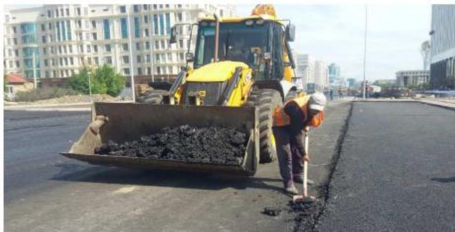
Рисунок 14 – Уборка срезанного асфальтобетона продольного рабочего шва
