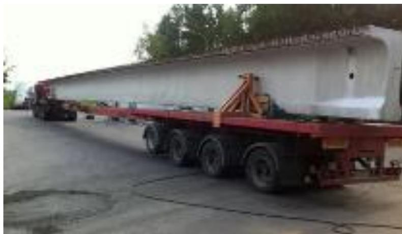
Рис. 3.3. Доставка балок пролетного строения
