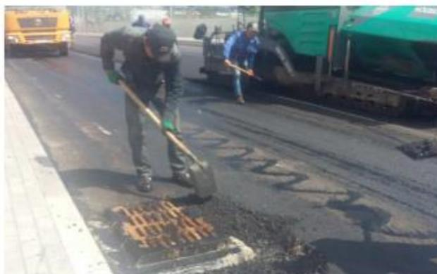
**Рисунок 11 – Ручная доработка при укладке асфальтобетона**
