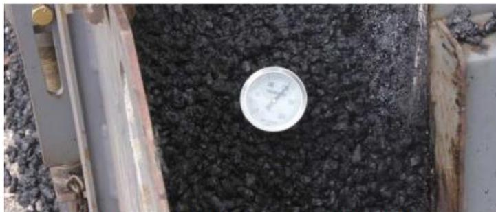
**Рисунок 8 – Замер температуры ЩМА в процессе укладки**
