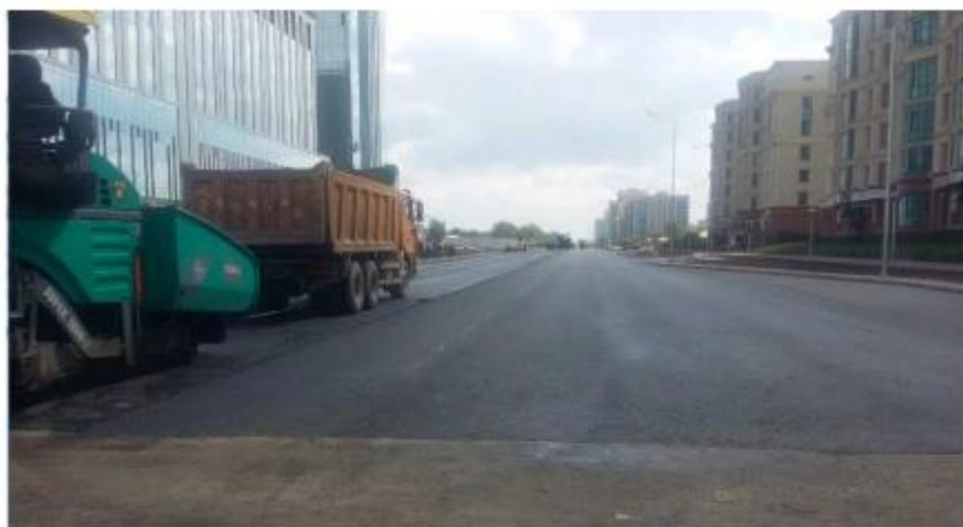
Рисунок 15 – Уложенный щебеночно-мастичный асфальтобетон одной полосы движения автотранспорта
