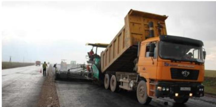
**Рисунок 7 – Укладка щебеночно-мастичного асфальтобетона (ЩМА)**
