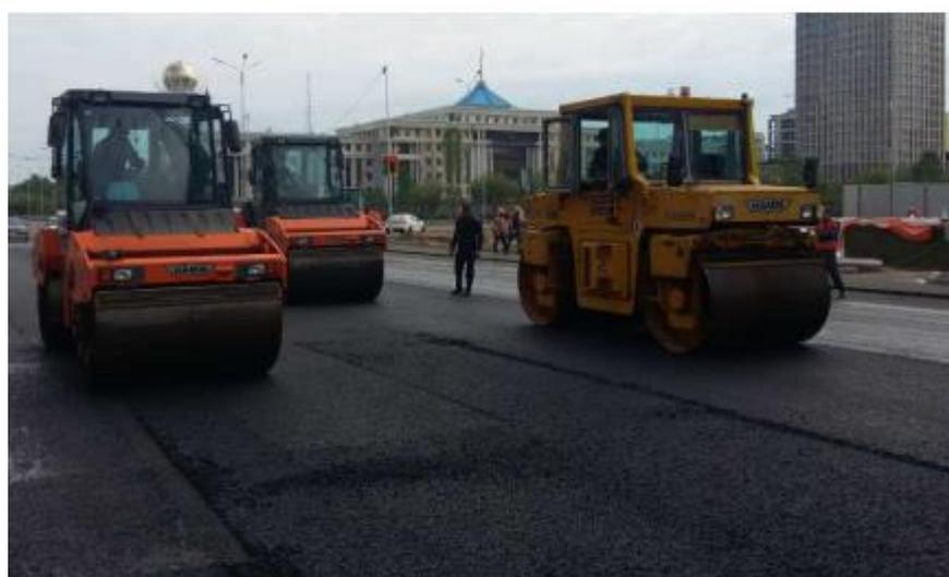
**Рисунок 16 – Уплотнение уложенного щебеночно-мастичного асфальтобетона**
