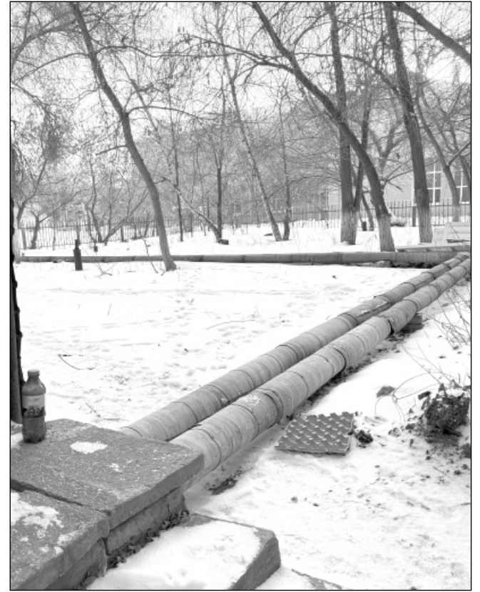
Ул. Толстого, 59. Участок теплотрассы в торце СК «Динамо» хорошо закрыли Фото Ольги ЛИХОГРАЙ
