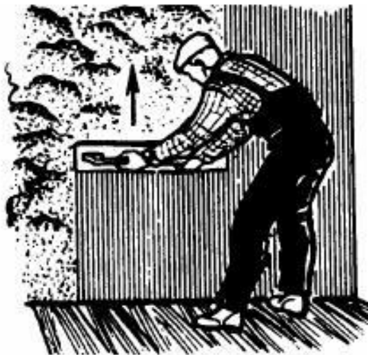
Рисунок 4 - Последовательное нанесение слоев обрызга, грунта
