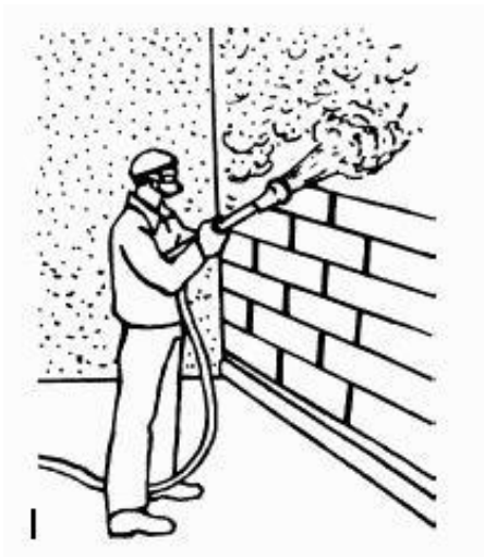
Рисунок 4 - Последовательное нанесение слоев обрызга, грунта
