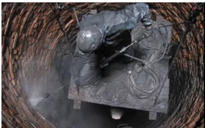
Рис.4 -Гидроструйный метод очистки до нанесения футеровки
