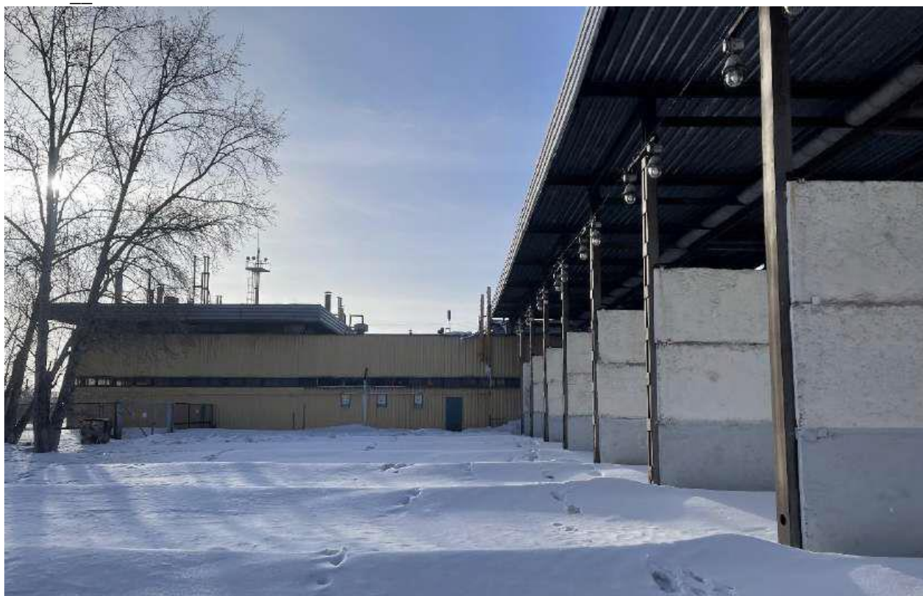
Фото 1. Общий вид обследуемой автомобильной газонаполнительной компрессорной станции (АГНКС) в г.Рудный.
